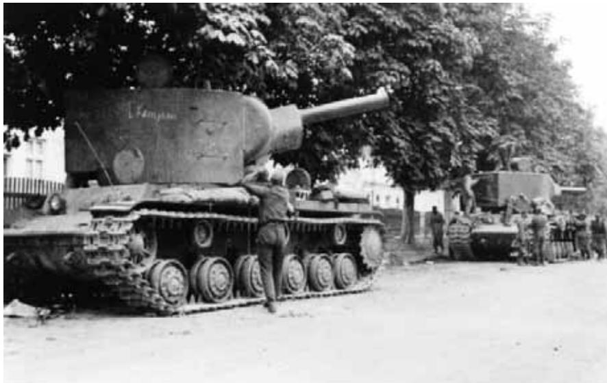
Два брошенных советских тяжёлых танка КВ-2. Башни развёрнуты в походное положение, пулемёты сняты: танки явно оставлены из-за неисправностей или отсутствия горючего при отступлении
